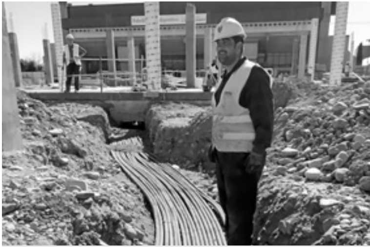
Instalación del sistema de geotermia. CEDIDA
