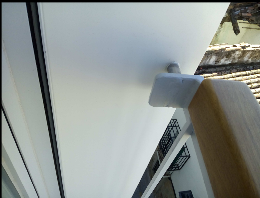
FIJACIÓN DE BARANDILLA A FACHADA
