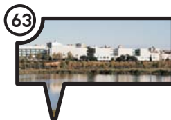
Sede de las Consejerías y Presidencia de la Junta de Extremadura. Emplazamiento Mérida, Badajoz. Promotor Junta de Extremadura. Arquitectos Juan Navarro Baldeweg. Arquitectos Técnicos Eduardo González Velayos, Miguel Lázaro Méndez. Colaboradores Franz Bucher, Rolf Brülisauer, J. Joaquín Lizasoain Urcola, Veronica Scortezzi, Pau Soler Serratosa, Lorenz Baumann, José María Gutiérrez de Churtichaga, Enrique Pujana Bambó, Miguel Rodríguez González, Jorge Meijide Tomás, Christopher Guest, Andrea Lupberger, Álvaro Galmés Cerezo, Julio Martínez Calzón (estructuras) Juan de la Torre (estructuras) Fechas 1992 P -1995 O Dirección de obra Juan Navarro Baldeweg, Franz Bucher y Rolf Brülisauer. Más información Revista El Croquis nº 73[III], 1995.
